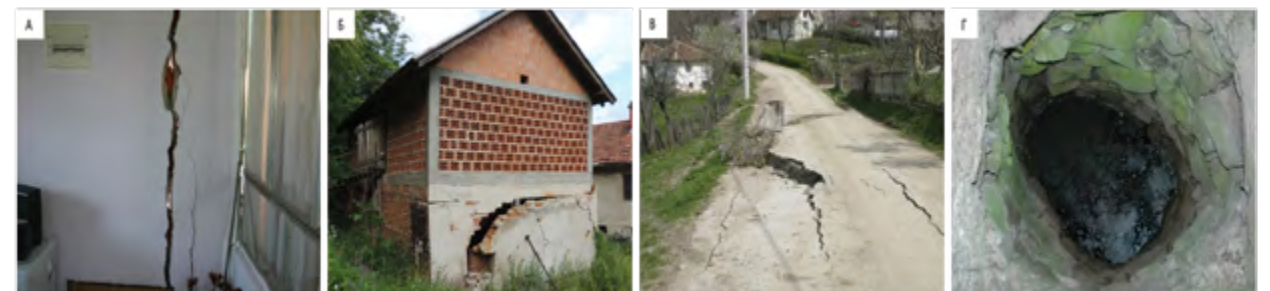
▼ Слика 3. Примери пукотина на грађевинским објектима. А) Рајкинац, Јагодина, 2006, Б) Шевица, Кучево, 2015; Тензионе пукотине и ожилјак на путу. В) Секурич, Рековац, 2006; Деформисан бунар. Г) Шуљковац, Јагодина, 2006–2010. Фото: М. В. Милошевић
