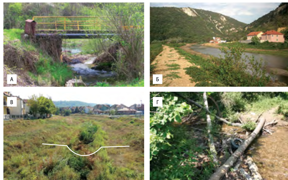
► Слика 4. Мостови као уска грла на водотоку. А) Лужница – Свође, Фото: Ј. Ковачевић-Мајкић; Неодржавани насипи. Б) Пек – Кучево, Фото: М.В. Милошевић; Неодржавано речно корито. В) Белица – Јагодина (бела линија означава попречни профил речног корита), Фото: М. В. Милошевић, Г) Јерма, Фото: М. Урошев
